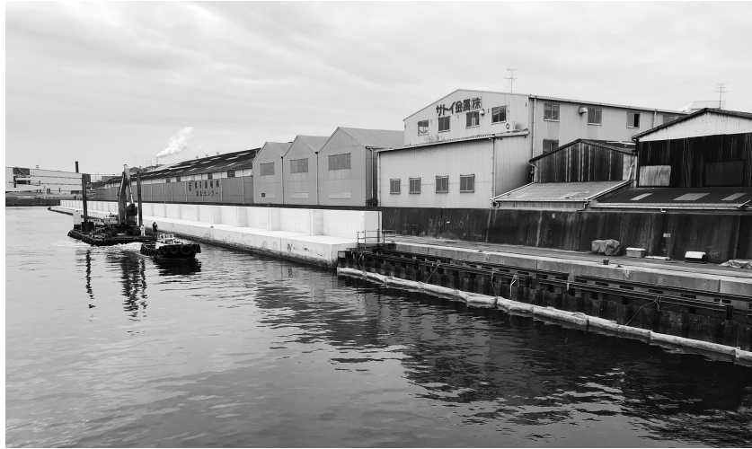
耐震化工事中の防潮堤(大阪市大正区鶴町1丁目。こはら議員提供)
